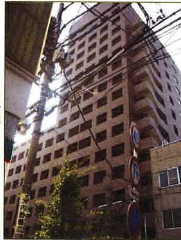
外観タイル貼り
